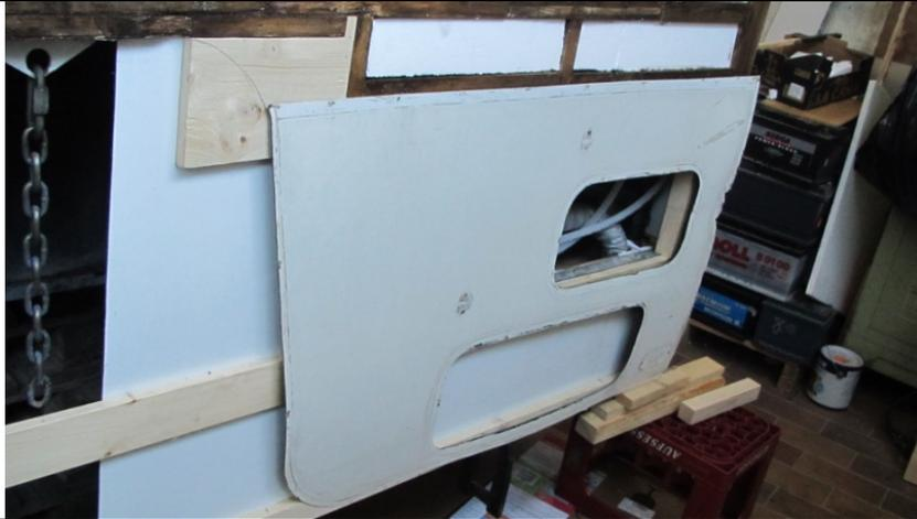
Schlechtes Holz entfernt und auf PSP-Platte neu aufgeklebt
