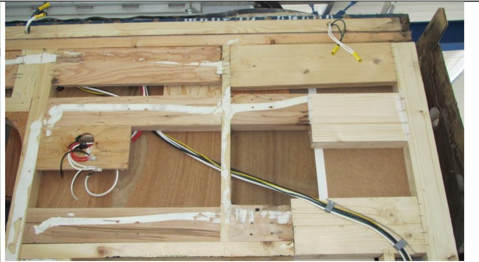
Hinten mitte rechts - Anschluß Hubstütze
